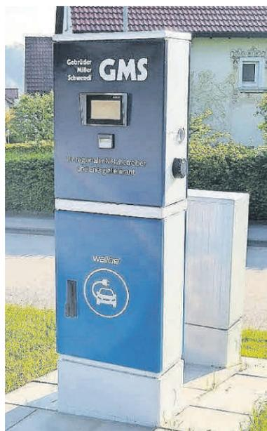
Es handelt sich hierbei um zwei AC-Ladepunkte mit jeweils maximal 22 kW. Diese Variante ermöglicht das kontaktlose Bezahlen mittels gängiger Kredit- und Debitkarten ohne Aufpreis. Die Ladesäule auf dem öffentlichen Parkplatz steht rund um die Uhr zur Verfügung. Neben der E-Ladesäule in der Reinstetter Straße in Hürbel verfügt die Gemeinde nun also über eine weitere Ladestation im Ortsteil Gutenzell.
