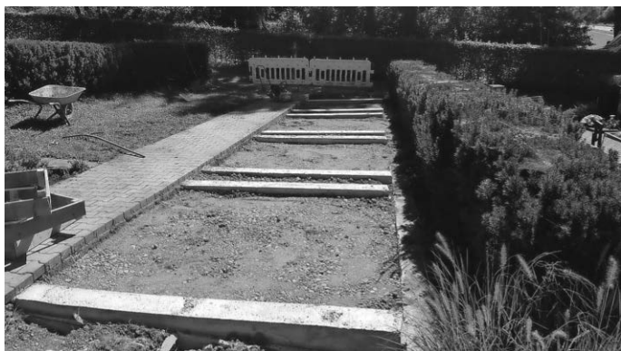
Anlegen von neuen Urnengräbern auf dem Friedhof in Hürbel
