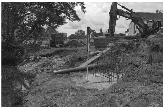
Diese wurden anschließend mit Beton angefüllt.
