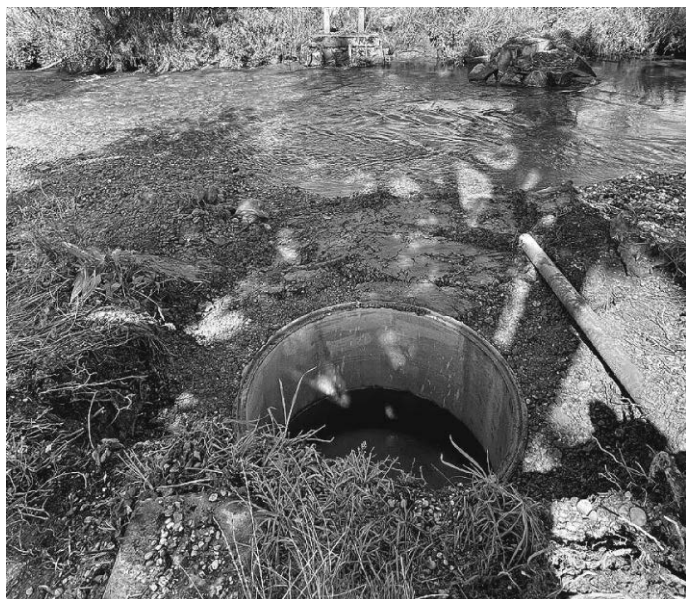
Zunächst wurden auf tragfähigem Grund Betonringe gesetzt.
