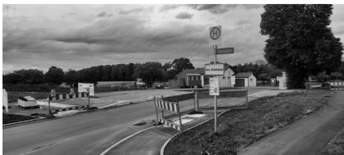
Bushaltestelle „Stockäcker“. Foto: Bürgermeisteramt
